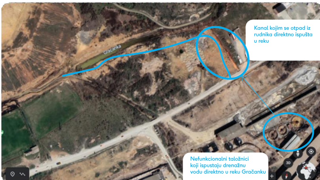
OO Slika 1: Taložnici i drenažni kompleks u rudniku Kišnica, Trepča
